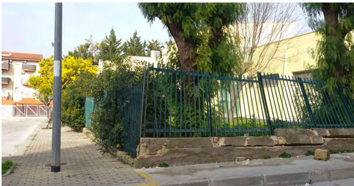
Particolare della recinzione sud
